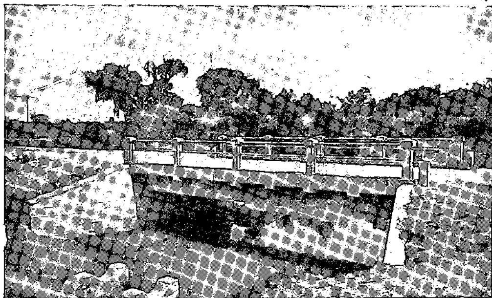
PONTE SOBRE O RIO ATUBA. 10 m. DE VÃO LIVRE
