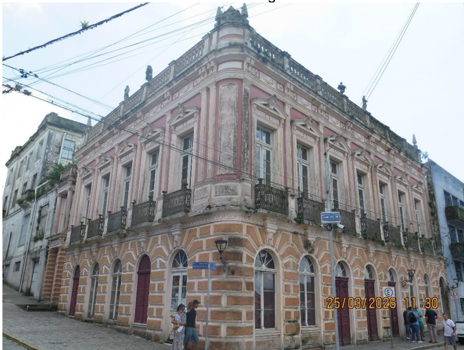
Figura 6 - Palacete Mathias Böhn, edifício histórico localizado no centro histórico de Paranaguá (PR), restaurado no início da década de 2010 e atualmente sem uso definido.
